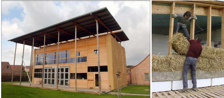
Strobalenbouw volgens de palen en balken methode (Architect Herwig Van Soom)
